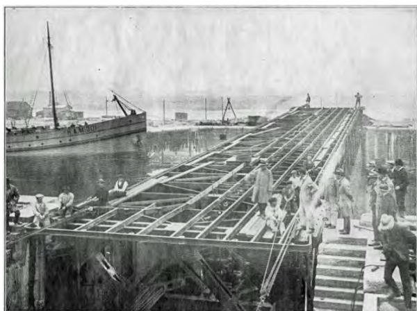
Fig. 18. Bovenaanzicht rùbdeur. Begonnen wordt met het in de kas trekken van de deur.
