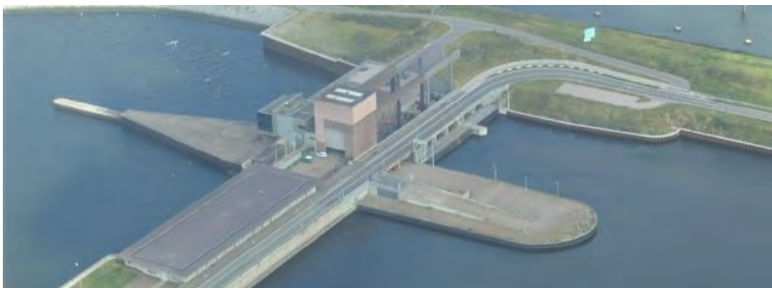
Het gemaal en spuisluis IJmuiden
